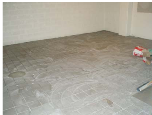
Kakling av ett av omklädningsrummen
